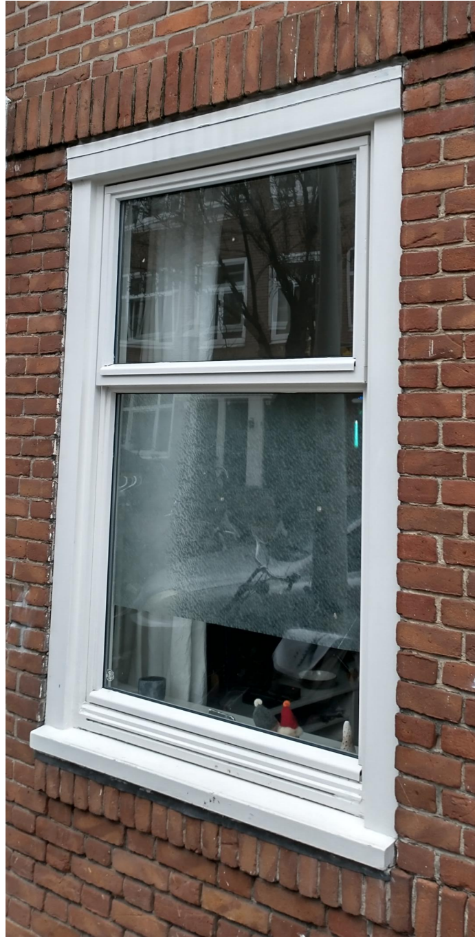
bestaand houten kozijn oorspronkelijk schuifraam
