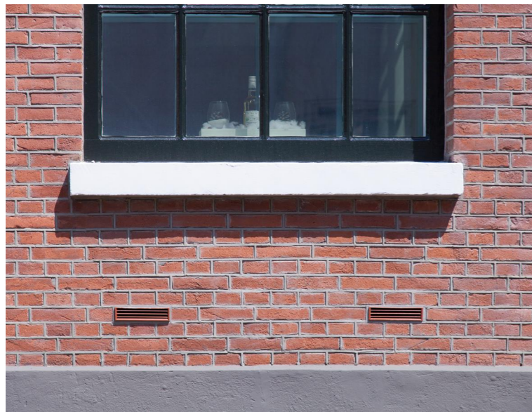
rooster in gevel ter grootte van een baksteen. Zelfs toegepast bij monumenten
