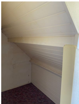
Locatie De plafondbetimmering van de nis in de slaapkamer.
