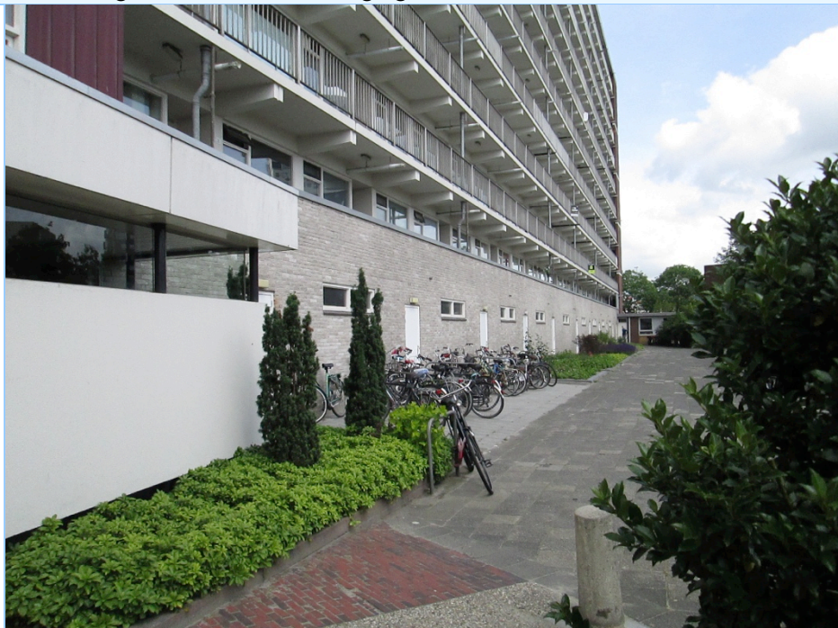
Foto 4. Zuidoost gevel met entree en bergingen
