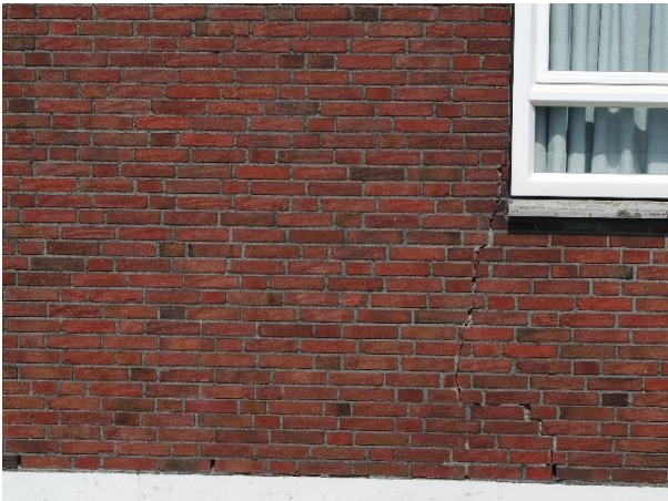
Foto 19: Scheur metselwerk
