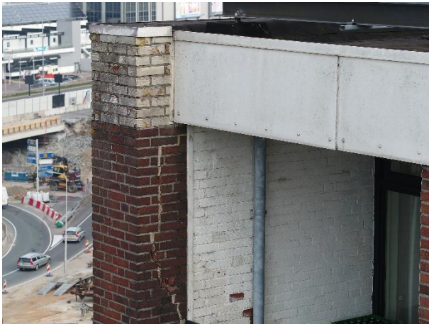
Foto 13: Scheur metselwerk
