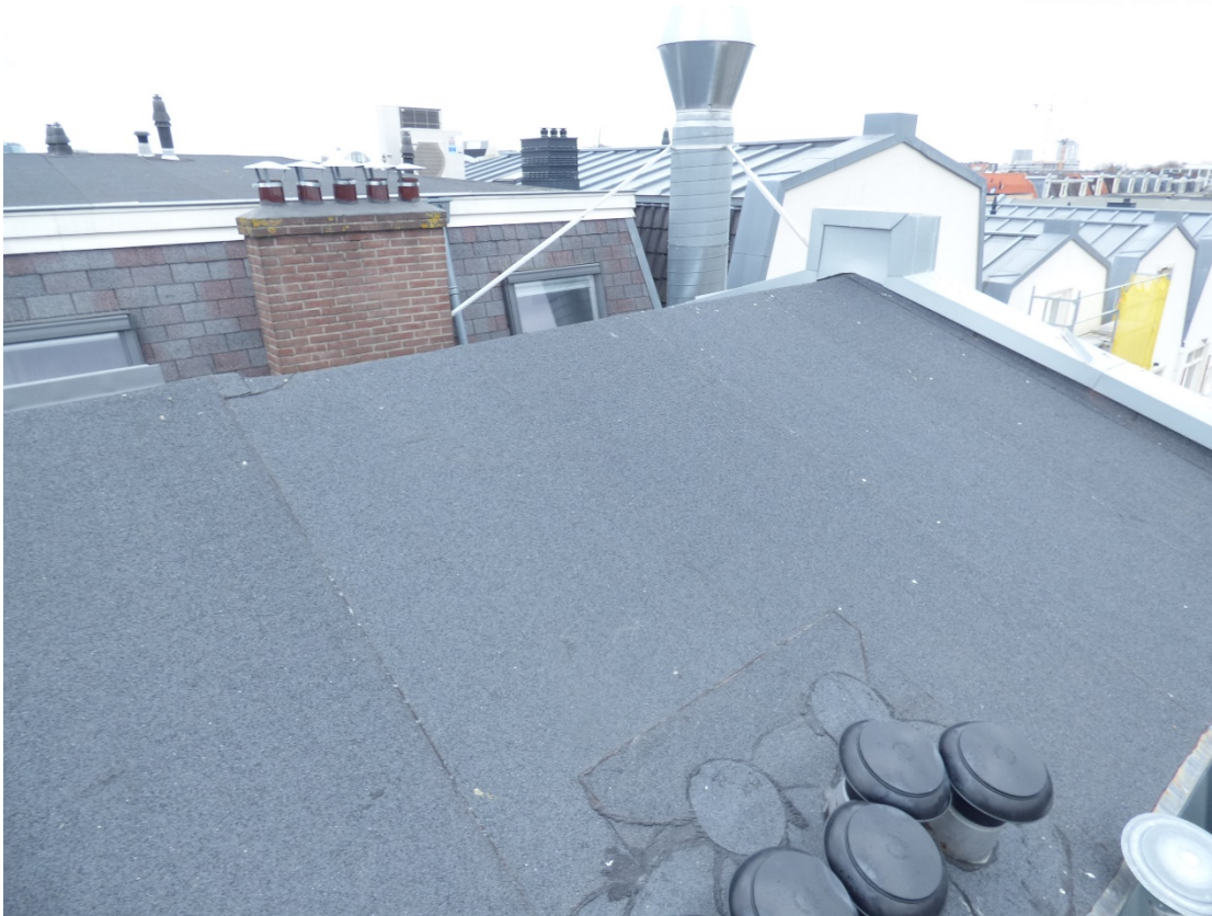
Dak met schoorstenen en dakdoorvoeren
