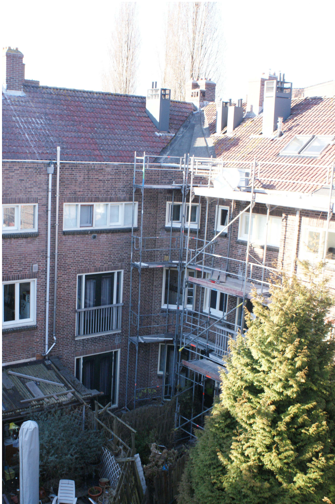
Foto 1. Bestaande achtergevel toegespitst op Bertelmanstraat 3
