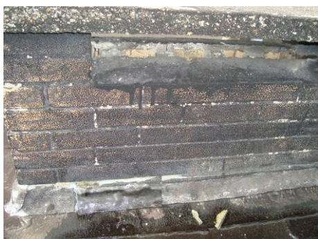
Gecoat metselwerk ventilatieschacht
