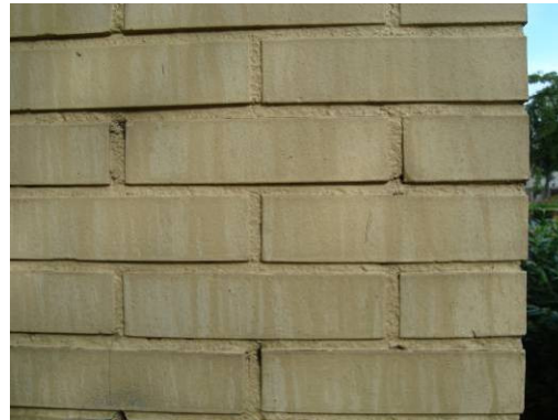
Metselwerk voorzien van sauswerk 1 e bouwlaag kopgevels
