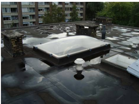
Lichtkoepel boven trappenhuis met klembeugels
