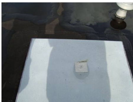
Reparatieplek zinken dakluik
