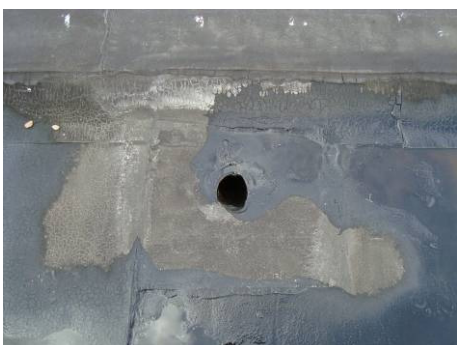
Craquelé dakbedekking en afvoer zonder bolroosters
