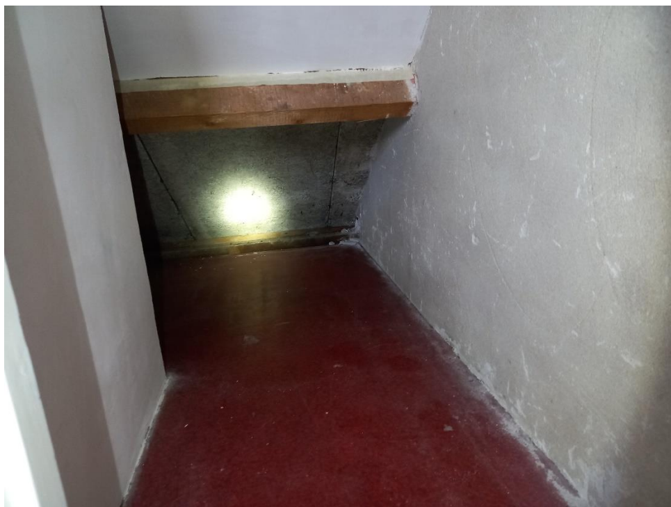
Foto 5: Zicht op de afwerking onder het dak met HWC (houtwolcement) plaatmateriaal en stucwerk.
