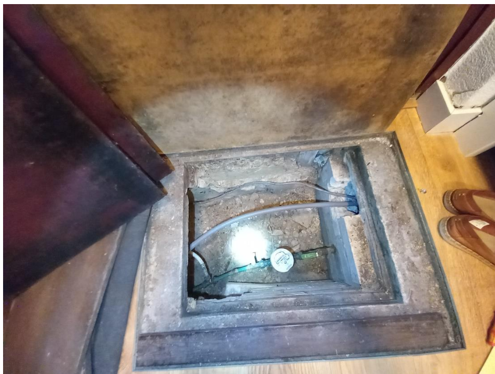
Foto 9: Zicht op de watermeterput met beperkt zicht in de kruipruimte onder de woning.
