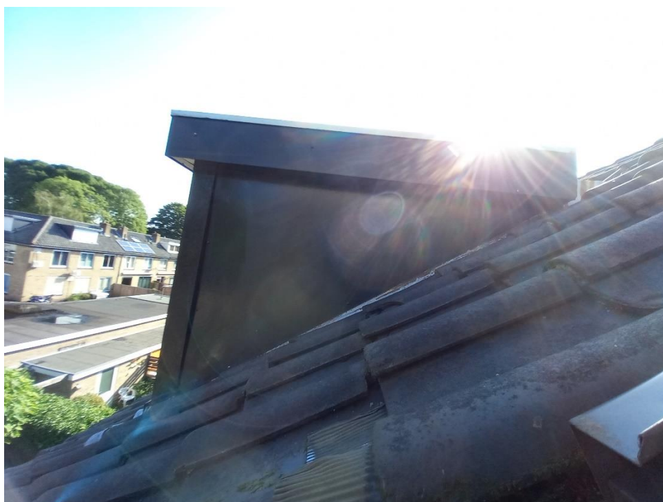
Foto 2: Zicht op de dakkapel met niet asbestverdacht plaatmateriaal.
