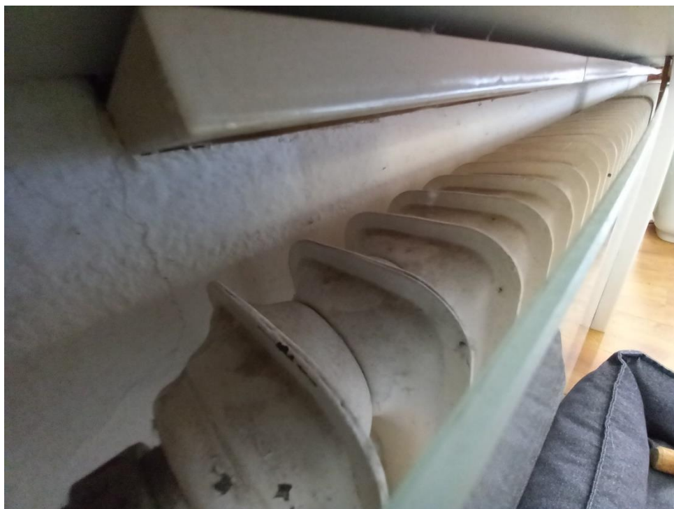
Foto 7: Zicht op een niet asbestverdachte vensterbank en ledenradiator.
