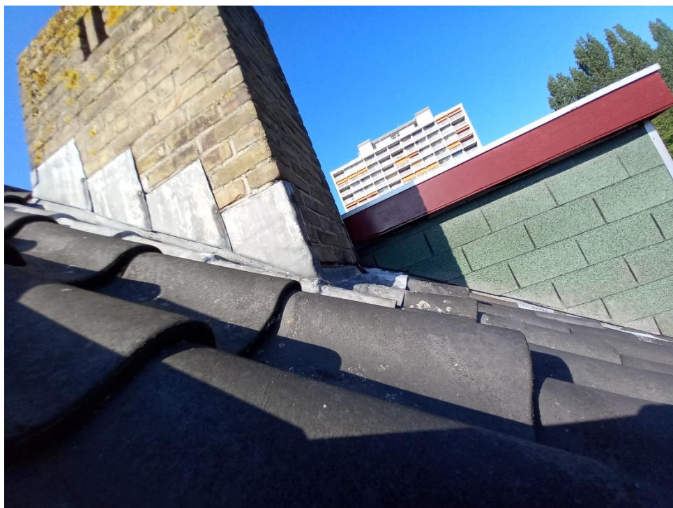
Foto 3: Zicht op het rookgasafvoerkanaal (zie beperkingen in § 4.3).
