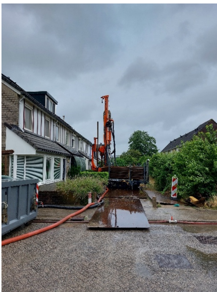
Boring van de bron
