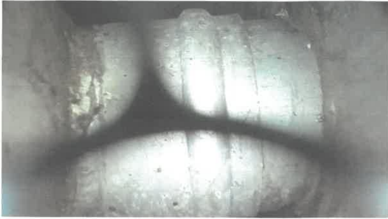
Condenswaterlekkage doorvoer.
