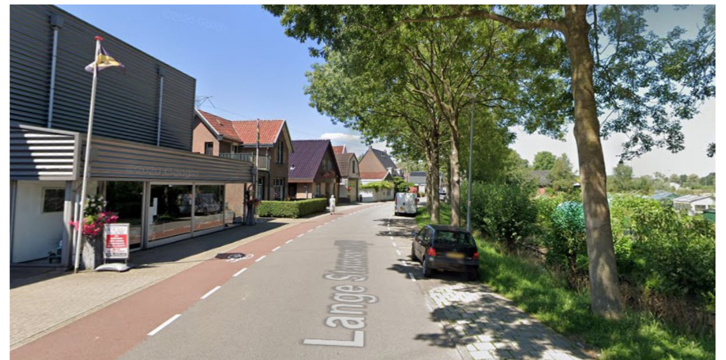
Figuur 2.4 Huidige situatie op Lange Stammerdijk West. De fietssuggestiestrook zal in de nieuwe situatie komen te vervallen en de straat zal worden ingericht conform het duurzaam veilig principe.
