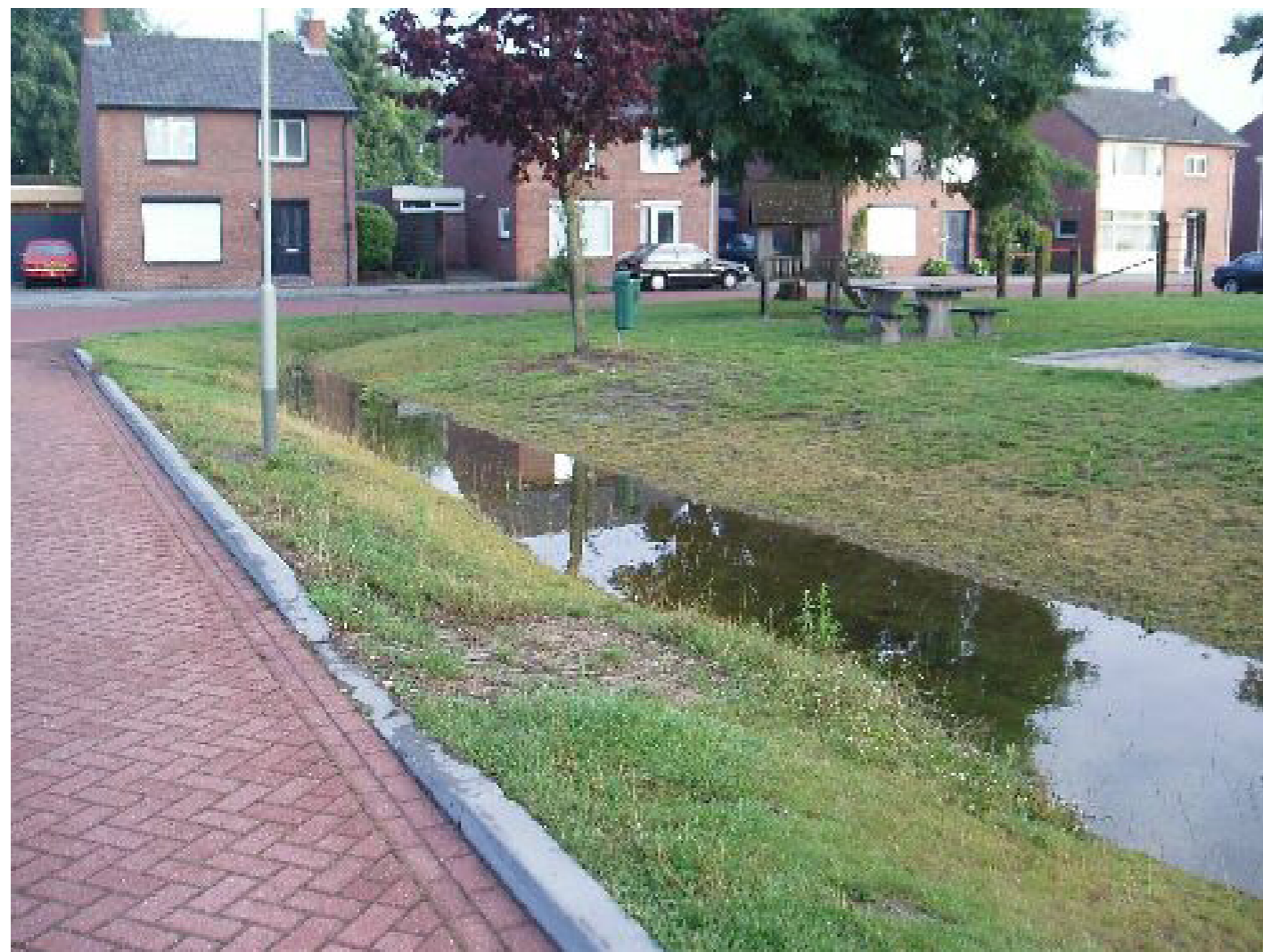
Figuur 1.2 Afvoer van regenwater op het oppervlaktewater waar de trottoirband wordt verlaagd.
