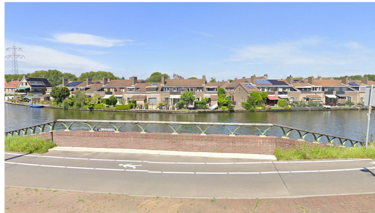
Figuur 3.26 De Geinboogbrug bij de kruising van het Zandpad en de N236
