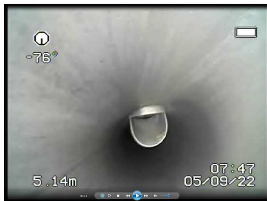
RGA ketelaansluiting in een CLV systeem
