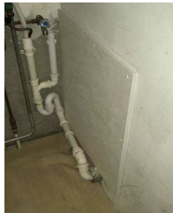
Aangebracht brandwerend inspectieluik
