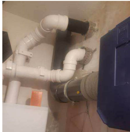
Vervangen RGA en LTV ketelaansluitleidingen met brandmanchetten
