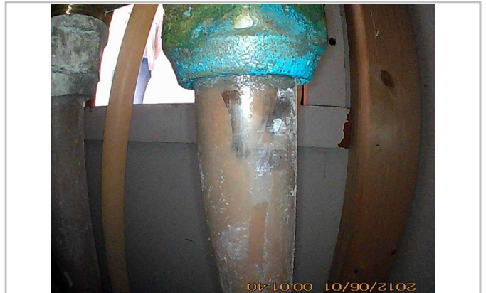
De koppelingen van de verdeler vertonen lekkage, en zijn geoxideerd.
