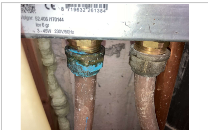
De koppelingen van de verdeler vertonen lekkage, en zijn geoxideerd.
