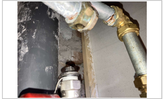
De knel kap vertoont lekkage in de kroon boven de verdeler.
