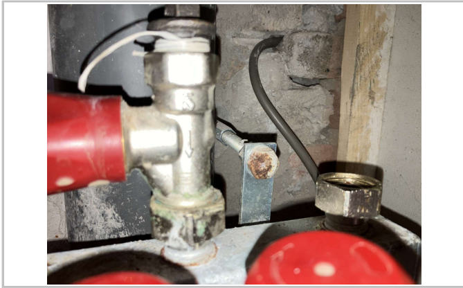
De verdelers is los gekoppeld van het leidingwerk.
