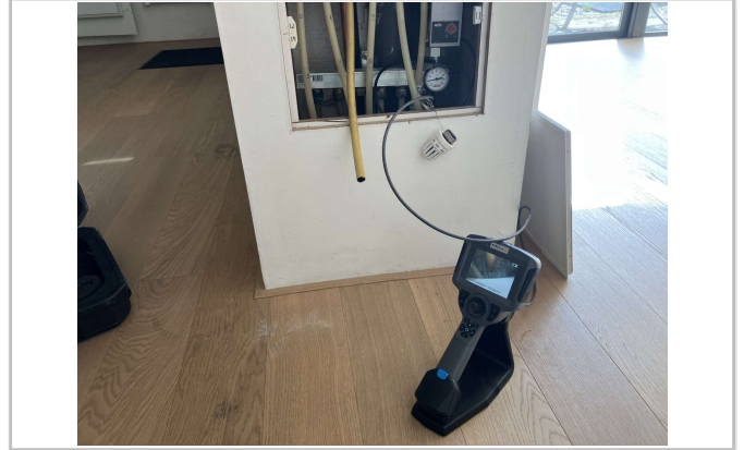
De verdeler van de vloerverwarming in de koof van de woonkamer, en inzet endoscoop.
