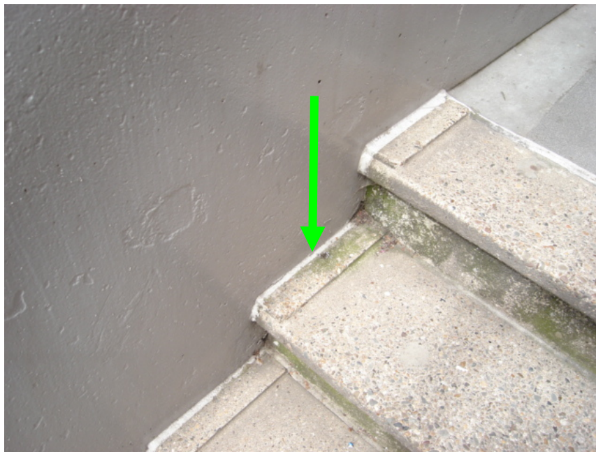
foto: 28, kit aansluiting traptreden
