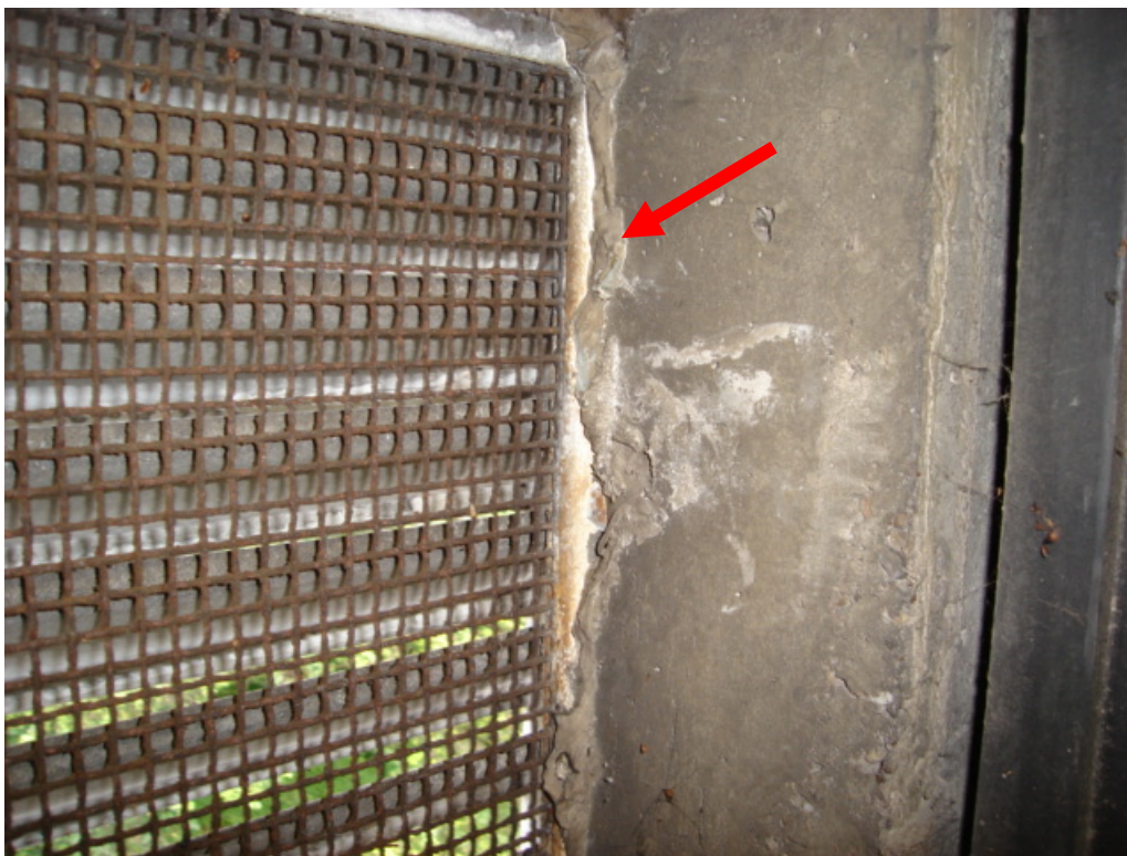
foto: 25, afdichting (kit)
