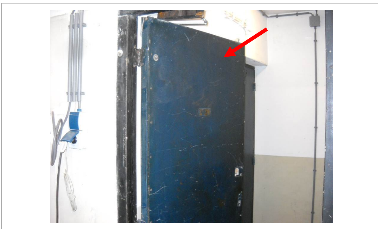
foto: 20, brandwerende beplating op deur (cement)
