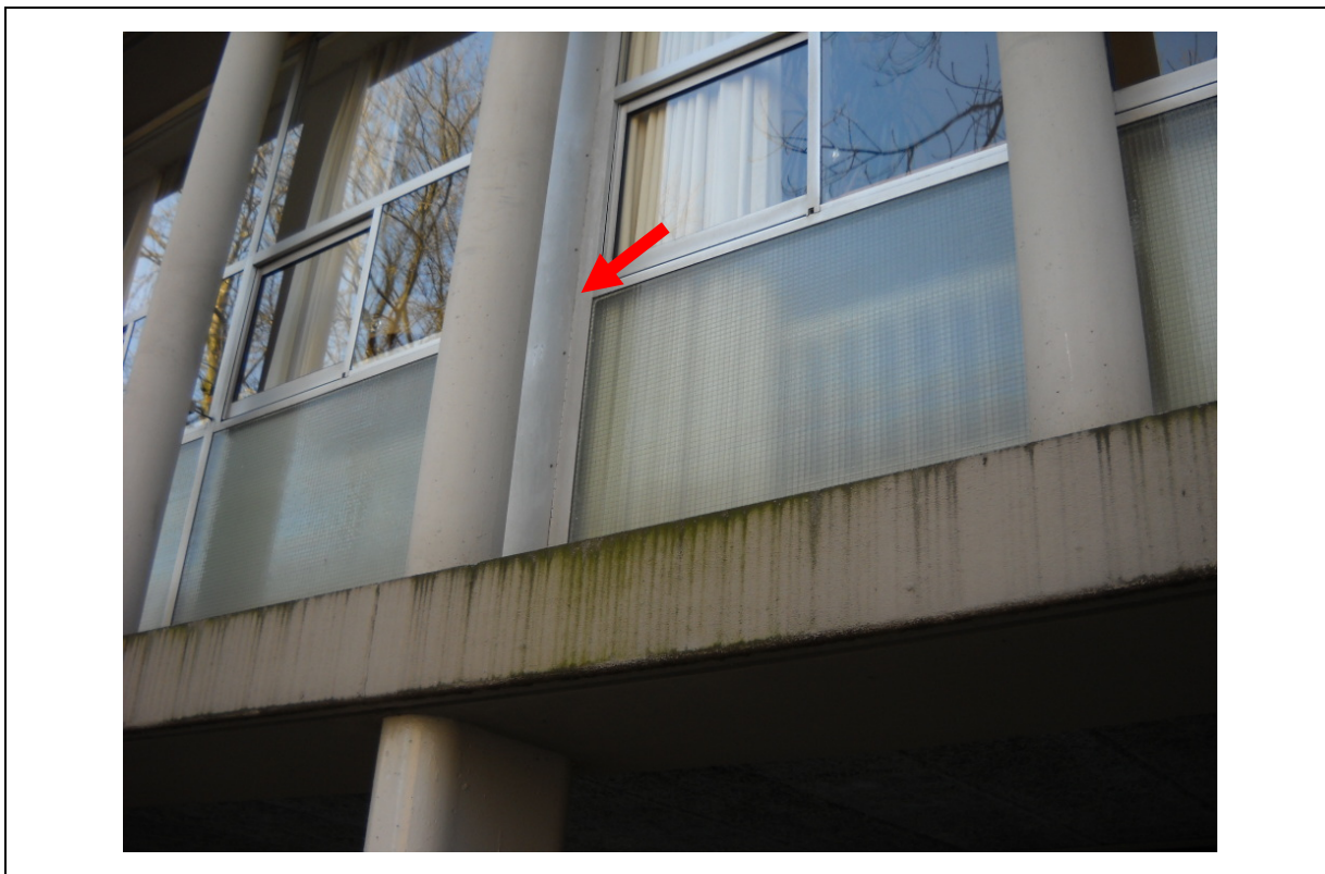
foto: 11, kit rond aluminium kozijnen
