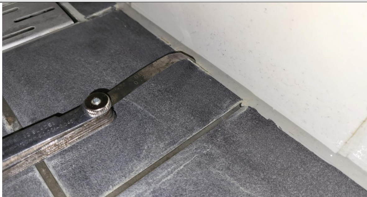
Loszittend kitwerk in de aansluiting van de douchevloer op de douchewanden
