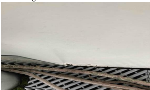
Aangetast hout in de puivullingen, het is beter deze te vervangen.
