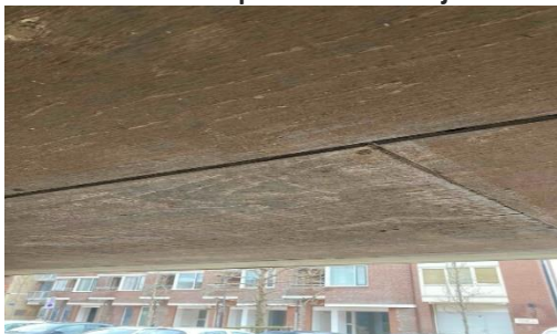
Verouderd verfsysteem en donkere kleuren zichtbaar op de plafond panelen
