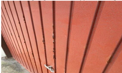
Roesvorming vanaf de kanten zichtbaar in de garagedeuren
