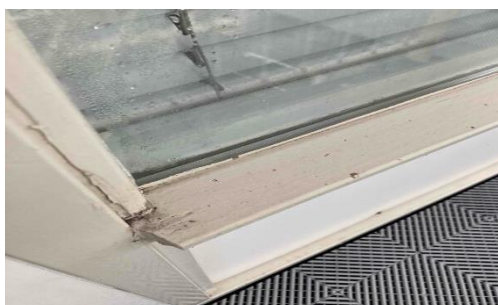
Ondeugdelijke aansluitingen tussen gevelement en glaslat
