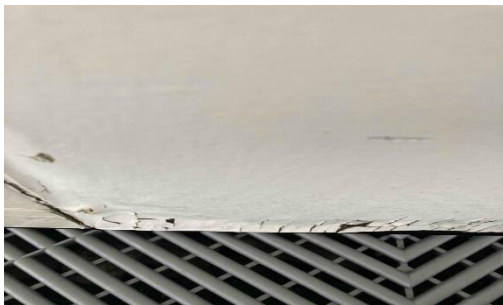
Vooraf bij de HWA's zijn de puivullingen aangetast, dit door langdurige vochtbelasting en inwatering
