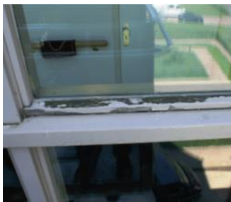
Voorbeeld defecten half beluchtende (type KOMO) glaslatten
