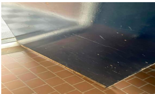
Mechanische schade in de deuren
