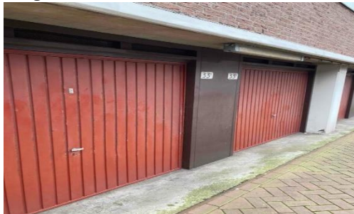
Verkleuring en poederen van het verfsysteem
