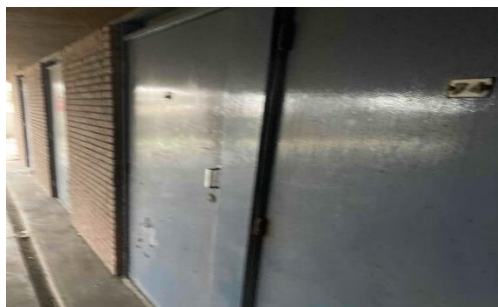
Vuilaanhechting en verouderd verfsysteem (doorloop)
