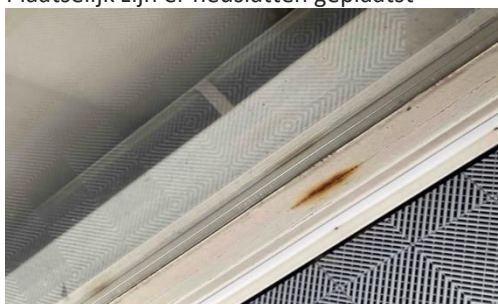
Roestige bevestigingen in de KOMO glaslat
