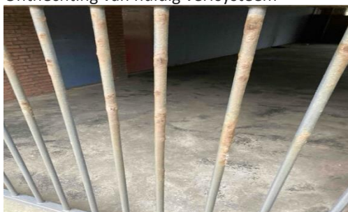
Roestvorming in de hekwerken benedenverdieping
