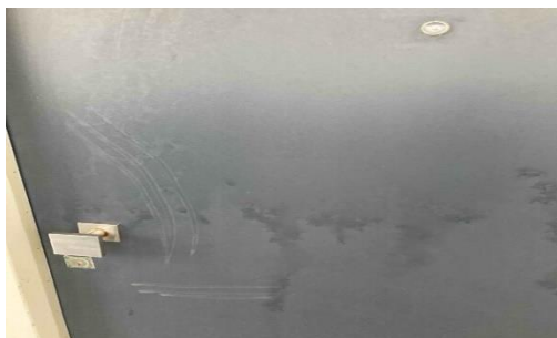
Verkleuring en poederen van verfsysteem
