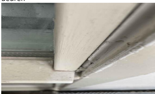
Plaatselijk onafgewerkte glaslatten
