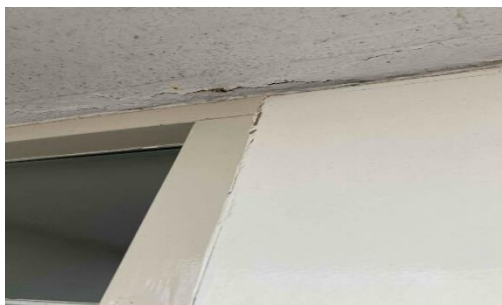
Ondeugdelijk voegvoorziening tussen puivulling en kozijn
