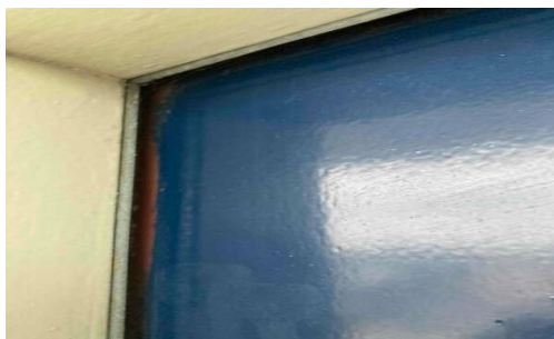
Plaatselijk zijn de deuren getordeerd en/of krom getrokken en sluiten deze niet meer goed af
