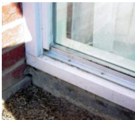
Verfgebreken rond aluminium stoetjesprofielen (condens vlak koud aluminium)
