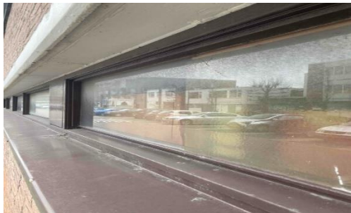
Kleur en glansverlies van het huidige verfsysteem
