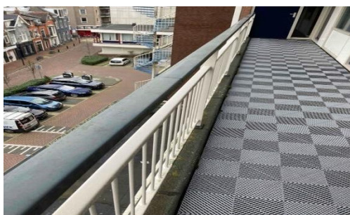
Verkleuring en poederen van verfsysteem
