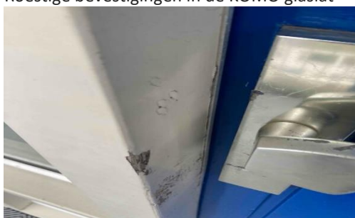
Mechanische schade in de deur
