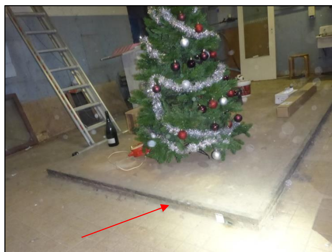
Foto 4: Technische ruimte: Golfplaat als bekisting (Bron 1)
