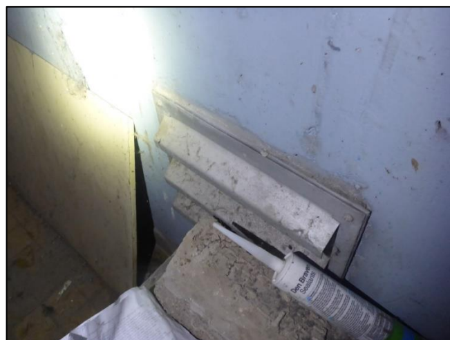
Foto 6: Technische ruimte: Ventilatiekanaal (Niet asbestverdacht)
