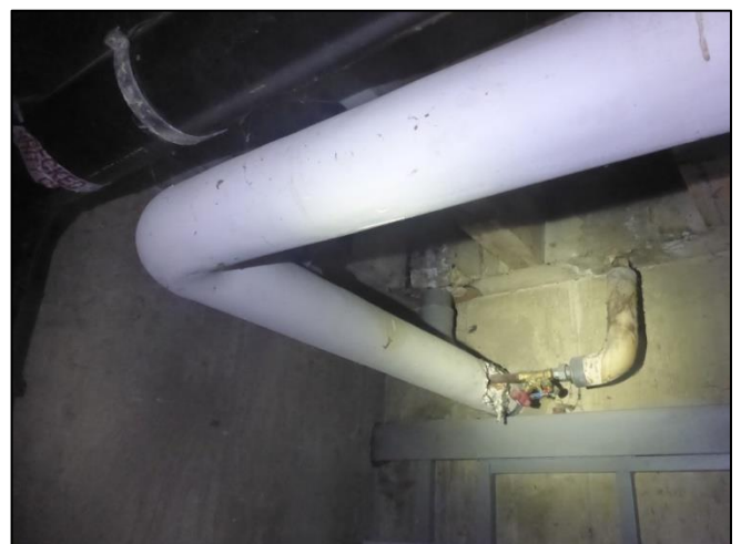
Foto 12: Technische ruimte: Leidingisolatie (Niet asbestverdacht)
