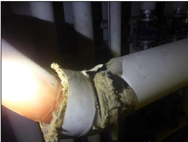
Foto 9: Technische ruimte: Leidingisolatie (Niet asbestverdacht)
