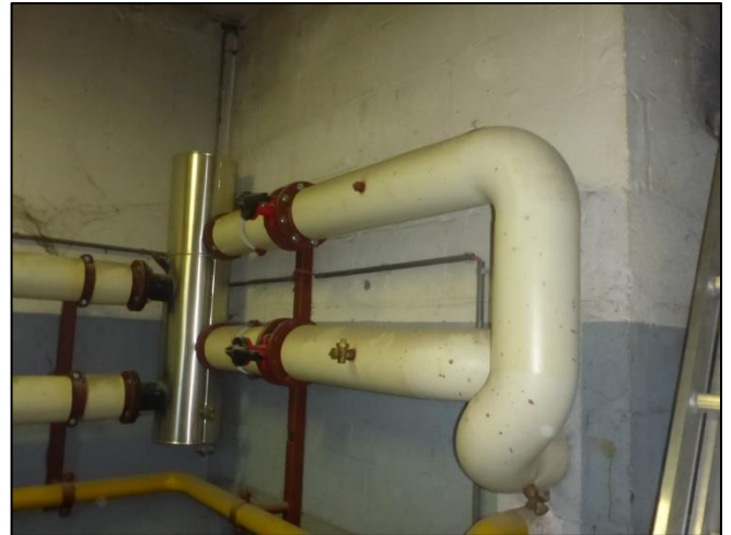
Foto 8: Technische ruimte: Leidingisolatie incl. flenspakkingen (Niet asbestverdacht)
