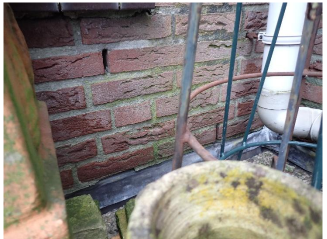
Foto 22 De lintvoeg komt los uit het metselwerk.
