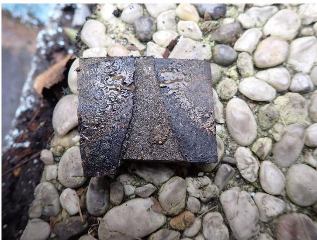
Foto 17 Vocht tussen de lagen van het dakbedekkingssysteem en geen goede verkleving tussen de lagen.
