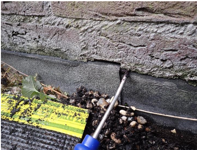
Foto 13 Beginnende onthechting overlapverbinding bij bitumen slabben.
