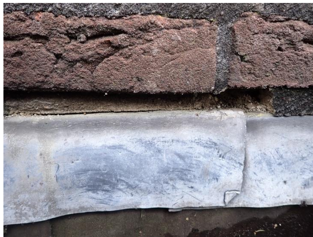
Foto 8 De lintvoeg komt los uit het metselwerk.
