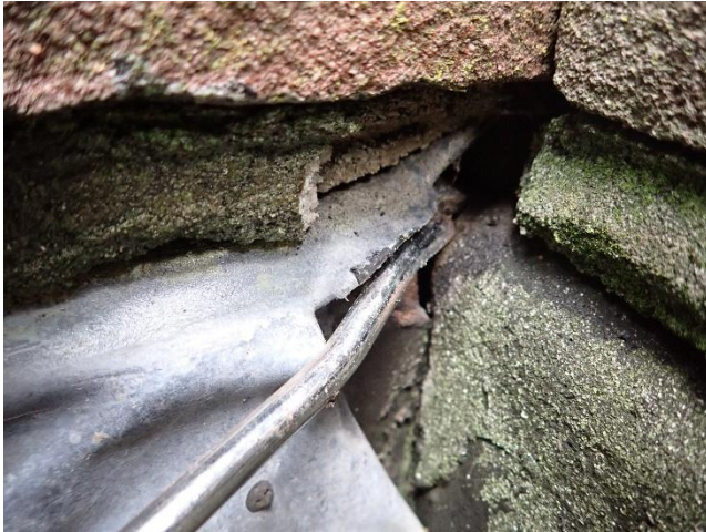
Foto 19 Inwateringspunt tussen aansluiting lodenslabben en bitumen slabben.
