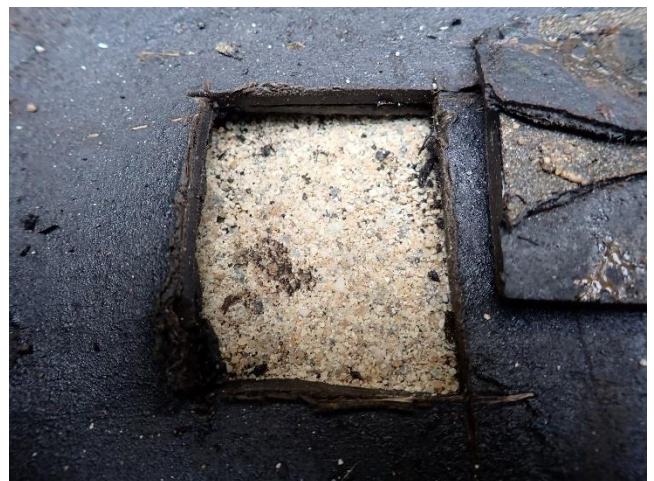
Foto 16 Insnijding 1 in het dakvlak, zandcement licht vochtig.
