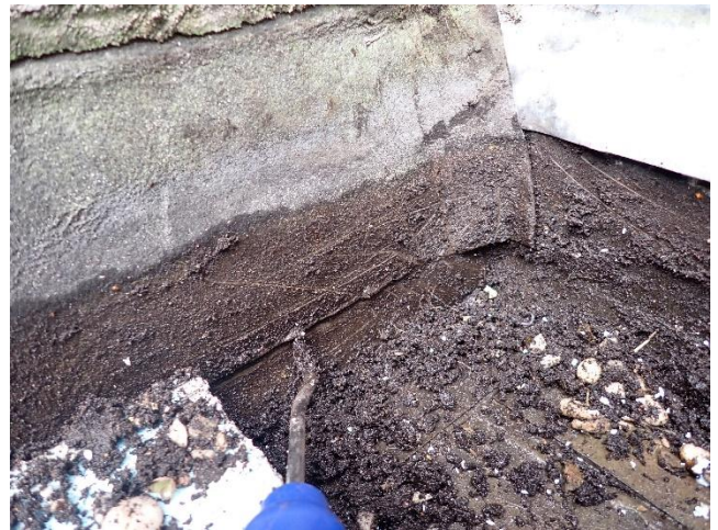
Foto 14 Beginnende onthechting overlapverbinding bij bitumen slabben met opstand.
