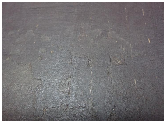
Foto 6 Loskomen van bovencoating van de toplaag van de dakbedekking, inlagen zichtbaar.
