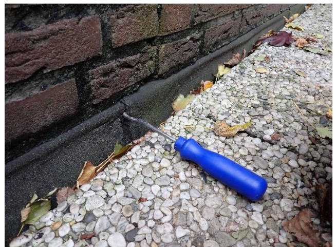
Foto 18 Beginnende onthechting overlapverbinding bij bitumen slabben.
