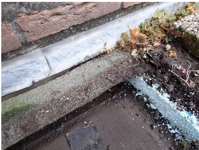
Foto 7 Opstandstrook dakbedekking onder het grind.
