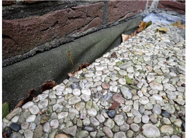
Foto 20 Scherpe plooien in de bitumen slabben.
