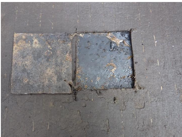
Foto 5 Vocht tussen de lagen van de dakbedekking en geen goede verkleefing tussen de lagen.
