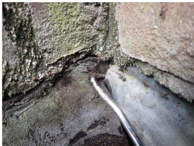
Foto 12 Inwateringspunt tussen aansluiting lodenslabben en bitumen slabben.
