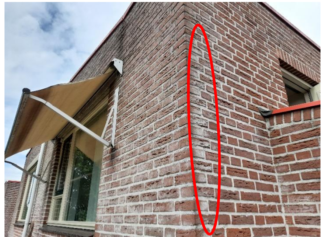
Foto 4 Verticale scheur op gebouw hoek.
