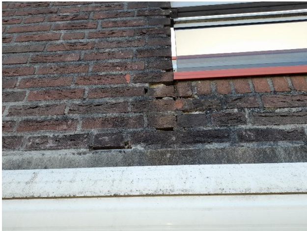
Foto 25 Vervuiling en uitgespoeld voegwerk bij afdekkappen.
