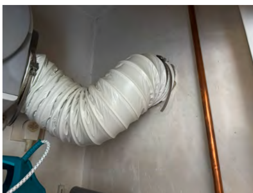
De leiding van de mechanische ventilatiebox is niet voorzien van een brandmanchet
