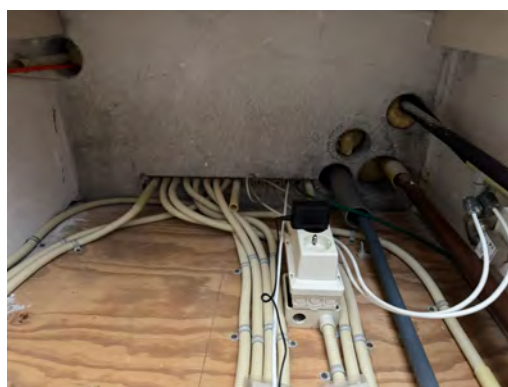
Leidingdoorvoeren van de meterkasten zijn niet voorzien van een brandwerende coating
