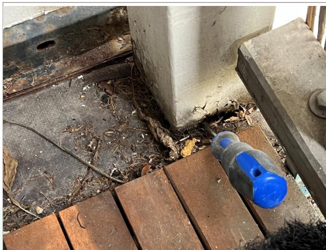
Foto 4: Appartement 259-3. Houtrotschade in linker kolom t.h.v. vloer.
