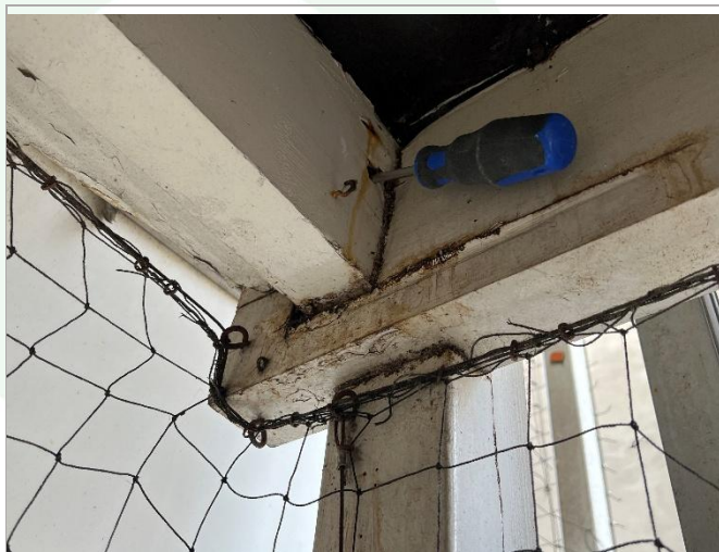
Foto 8: Appartement 259-2. Houtrotschade in dwarsligger (uiteinde met langsligger buitenzijde).
