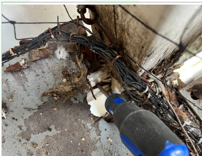
Foto 11: Appartement 259-2 / 259-1. Houtrotschade in vloer en in dwarsligger onderliggende appartement.
