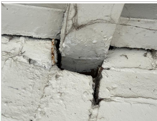
Foto 7: Algemeen: Detail aansluiting dwarsligger met de gevel. Zichtbaar is dat het hout in de constructie onbehandeld is. Visueel ziet dit er goed uit.
