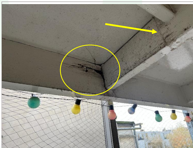
Foto 2: Appartement 259-3. Houtrotschade in de langsligger buitenzijde en eerder uitgevoerde herstelwerkzaamheden aan dwarsligger.
