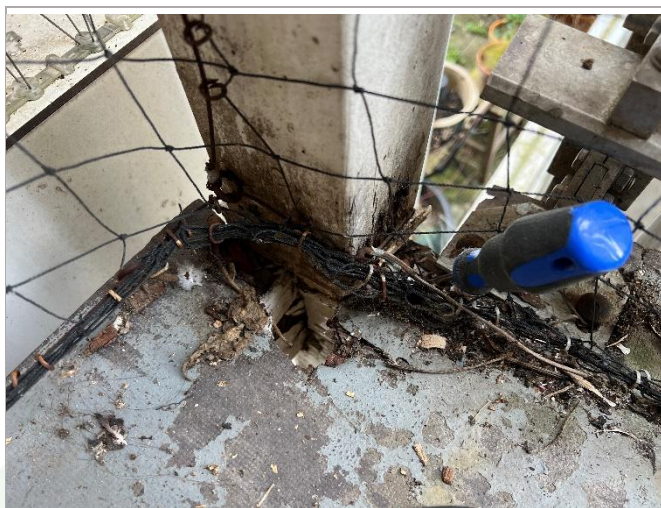
Foto 10: Appartement 259-2 / 259-1. Houtrotschade in vloer en bovenzijde langsligger onderliggende appartement.
