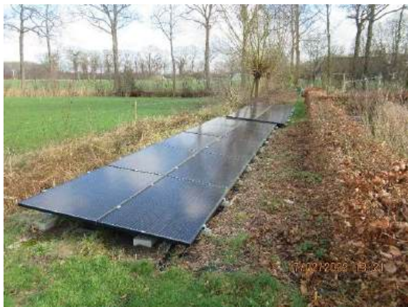
Landopstelling met 18 stuks zonnepanelen in vrijwel vlakke positie.
