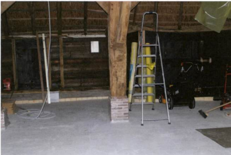
Gebintkolommen op gemetselde stiepen. In de schuur is een betonvloer gestort, die constructief los is gehouden van de stiepen. Op de vloer zijn geen sporen aangetroffen van houtborende insecten.
