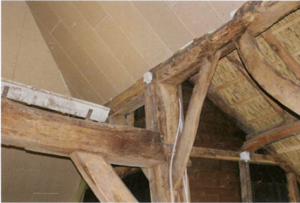
Gebintconstructie met dwarsligger, langsplat, korbeel en schoren.
