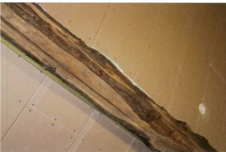
Detail dwarsligger in het midden van de overspanning. Geen tekenen zichtbaar die doen twijfelen aan de capaciteit van de balk
