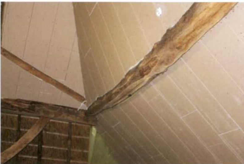
Dwarsligger in het wolfseind, Sterk doorgebogen door kruip door de langeduur belasting van de kap. Geen tekenen om te twijfelen aan de draagkracht van de balk.
