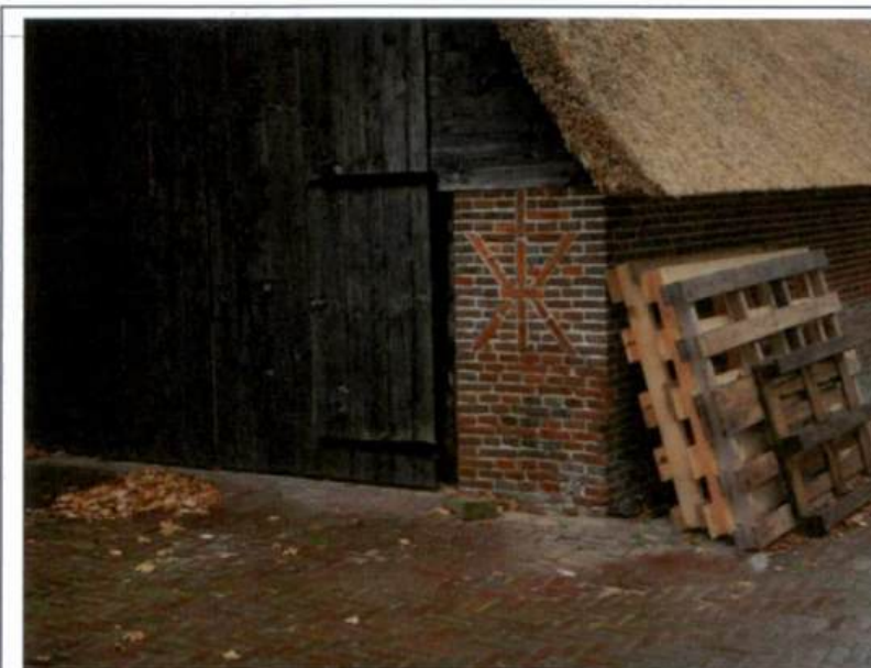
Rechterzijde - metselwerk met inlage
